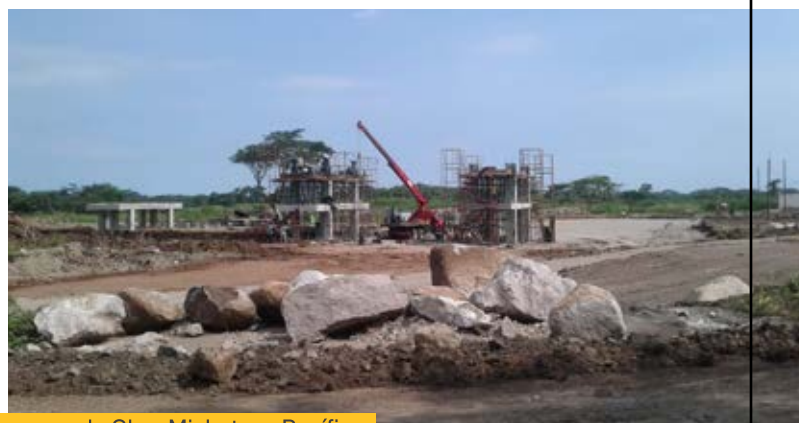
Avances de Obra Michatoya Pacífico
