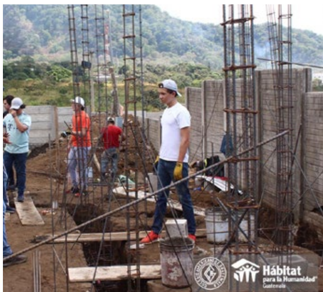
Estudiantes apoyando a construir casas que fueron afectadas por el volcán de fuego.
